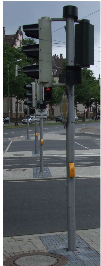
Lichtsignalanlage mit akustischem und taktiler Zusatzsignal (Lautsprecher oben, Vibrator an der Unterseite des Tasters)
