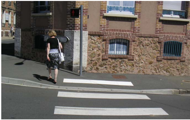
Noppenplatten vor Bordabsenkung in Chartres (Frankreich)
