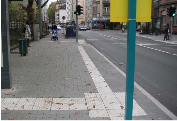
Einstiegsfeld mit Rippen, Noppen im Auffindestreifen in Frankfurt
