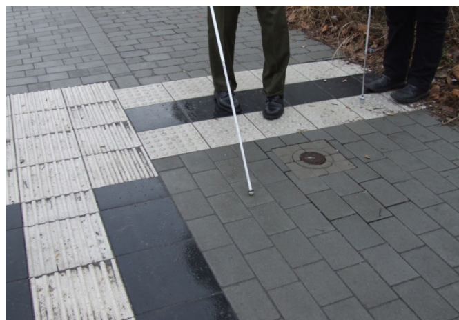
Auffindestreifen mit auseinandergelegten Noppen an Haltestelle in Mörfelden-Walldorf (Hessen)
