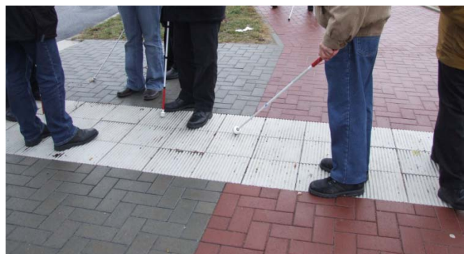
Rippen im Auffindestreifen an einer Haltestelle in Erlensee (Hessen)
