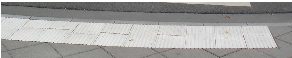
Rippenplatten gemäß Leitfaden 'Unbehinderte Mobilität' als Richtungsfeld an einer Querungsstelle in Frankfurt
