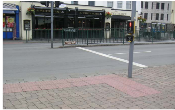
Noppenplatten vor Bordabsenkung in Guernsey (Großbritannien)
