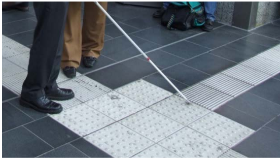
Leitstreifen und Abzweigefeld, Hauptbahnhof Frankfurt
