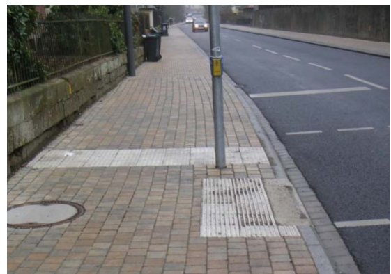
Sperrfeld vor Nullabsenkung in Marburg
