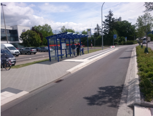
Abb. 4: Haltestelle am Fahrbahnrand in Groß-Gerau. Der Mittelstreifen verhindert oft gefährliche Überholvorgänge und außerdem auch das Parken im Haltestellenbereich.
