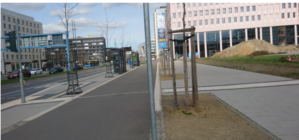
Abb. 11: Breiter Radweg zwischen Gehweg und Wartebereich in Chemnitz. Zur Führung über den Radweg wurde ein Pflasterstreifen verlegt, Bodenindikatoren (Rippenplatten) sind hier nicht zulässig
