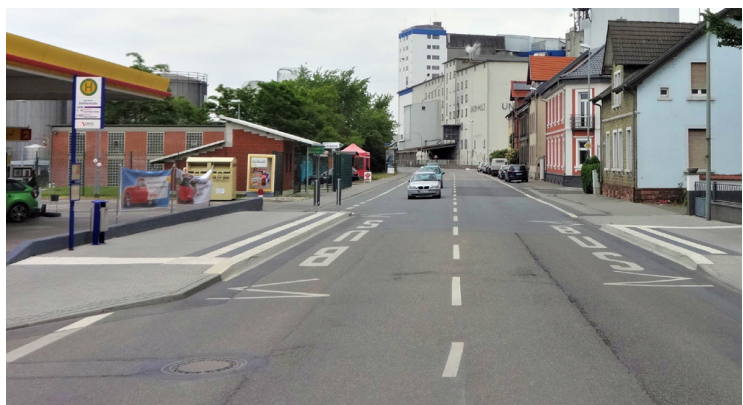
Abb. 5: Haltestellenkap in Gernsheim. Ohne Kap wäre die Wartefläche bei dem schmalen Gehweg zu klein
