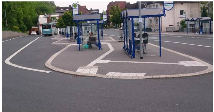
Abb. 8: Busbahnhof Herborn. Die versetzten Taschen erleichtern das dichte Anfahren des Bordes. Ein Leitsystem führt zu den Haltepositionen und den Einstiegsfeldern an der 1. Bustür
